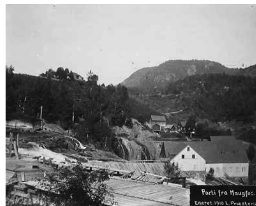
Øvre Haugfoss pukkverk
